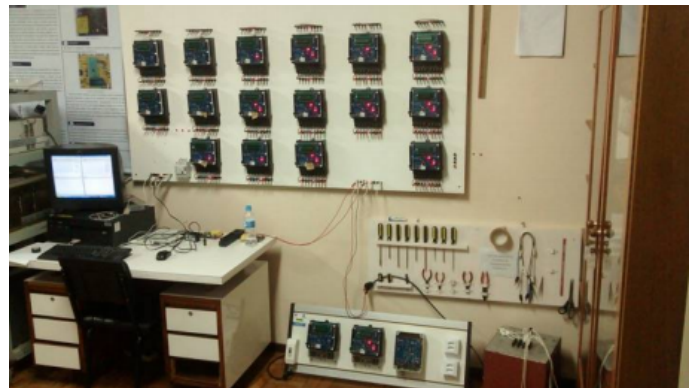
Fig. 8. Painel de testes dos medidores.
